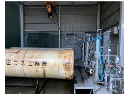
高圧ガスの冷却用の水を循環して利用
