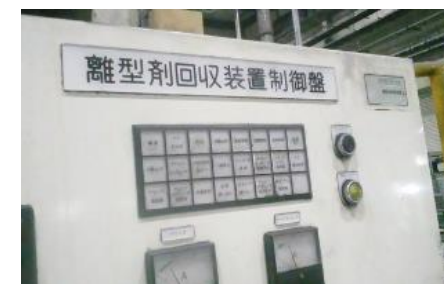
鍛造工程にて離型剤回収装置を使い、 離型剤を再利用
