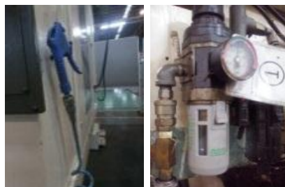
点検を実施したエアーガン、フィルター
