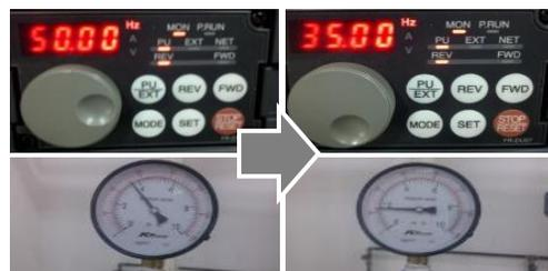
冷却水ポンプのインバーター制御
